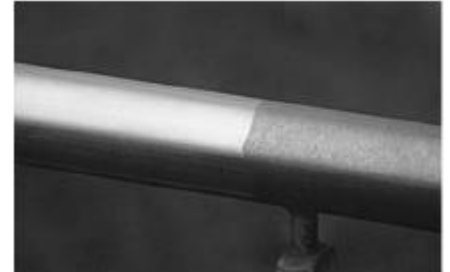
Handlauf nach und vor der Reinigung Handrail before and after cleaning
